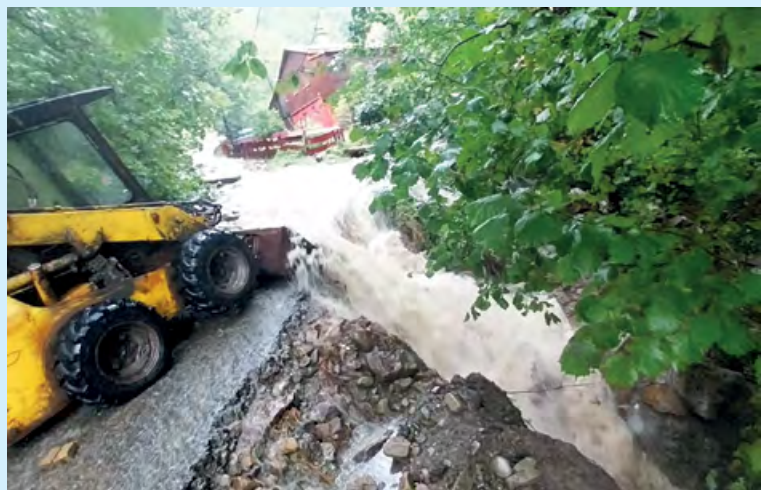
Povodně páchaly škody i v Malenovicích.
