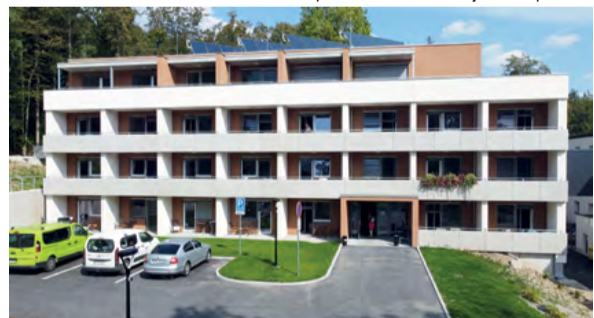
Léčebný dům Dr. Storch II spojuje s původní budovou chodba v prvním patře (na snímku je zcela vpravo vidět její část), kterou se pacienti dostanou pohodlně do nové jídelny a na pracoviště procedur.
