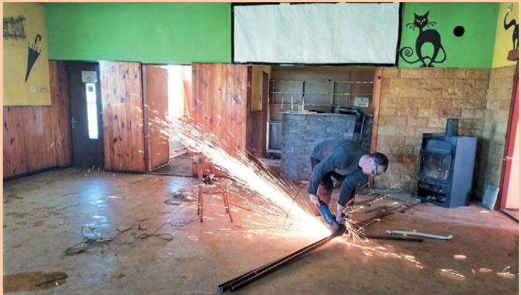
Příprava na výstavbu nového sportovního zázemí pro sportovce i občany obce zdárně pokračuje. Členové Sportovního klubu Metylovice uspořádali brigádu a společně vyklízeli prostory nynějšího zázemí. Demontovali vnitřní zařízení, jako například topení, bourali venkovní přístřešek atd.
