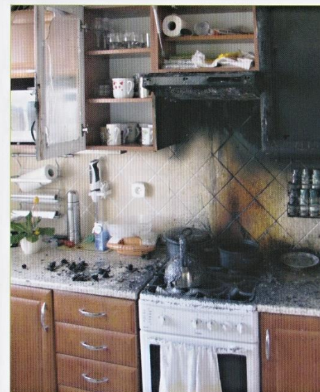
Kuchyně po požáru při vaření bez dozoru.
