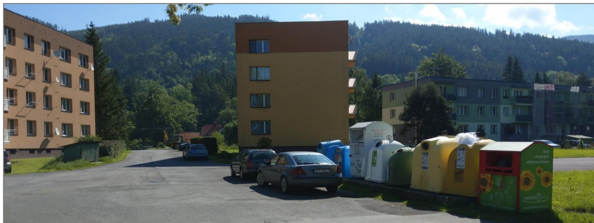
Obrázek 14: Nevhodně umístěné stanoviště Sídliště
